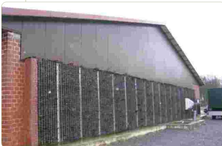
FIGURA 47. Biofiltro instalado en una explotación ganadera
